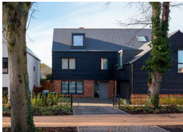
1. En plus d'avoir été implantée de façon à préserver une rangée de tilleuls, la volumétrie s'inspire de l'architecture vernaculaire locale. The Avenue, Pollard Thomas Edwards, Royaume-Uni
