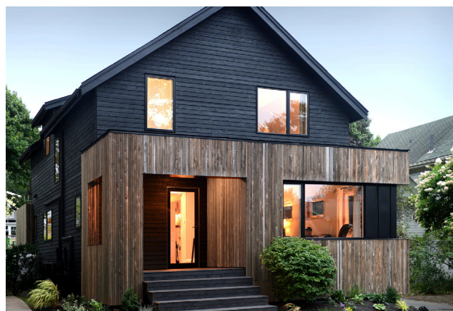
2. La volumétrie de cette résidence respecte l'échelle des autres bâtiments environnants. Elmhouse, Peter Braithwaites architectes, Canada
