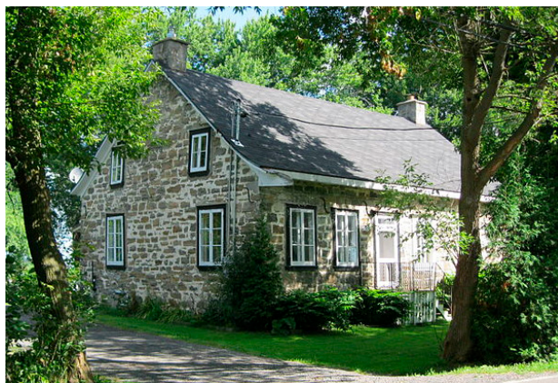
1. Maison Eustache-Rouleau, construite en 1836. 294, chemin de Senneville
