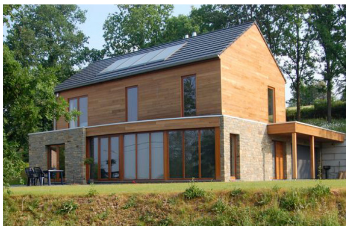
3. Socle recouvert de maçonnerie surmonté d'un parement léger en bois. Maison bioclimatique, Eric Lamblotte Benoît Straeten, Belgique
