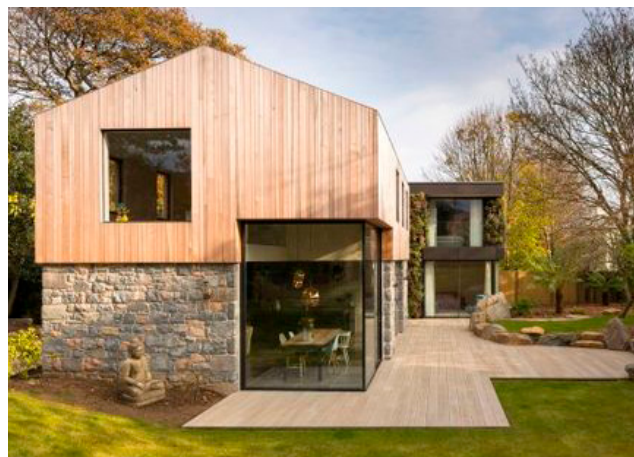
4. L'implantation et la volumétrie de cette maison ont été déterminées de façon à préserver le réseau racinaire d'arbres protégés. De plus, la volumétrie en "L" permet de rendre l'ensemble moins imposant. The Glade, DLM Architects, Royaume-Uni
