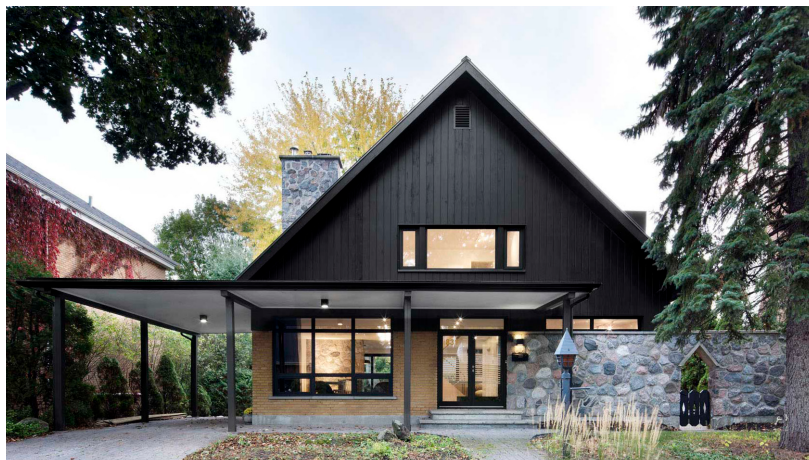
1. Toit à deux versants avec une pente forte habitée formant un pignon en façade. Résidence Closse, Nature Humaine, Canada
