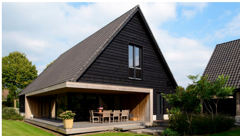
5. Toit habité à deux versants ayant une forme distinctive. Veghels Buiten, Leenders Architectes, Pays-Bas
