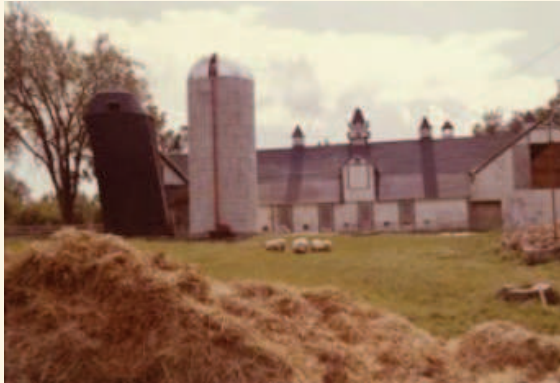
Le noyau du domaine agricole comprenant les principaux bâtiments de ferme. Source : Archives personnelles Mme Barbara Corbett Johnson, s.d., dans Lafontaine Soucy, 2016.
